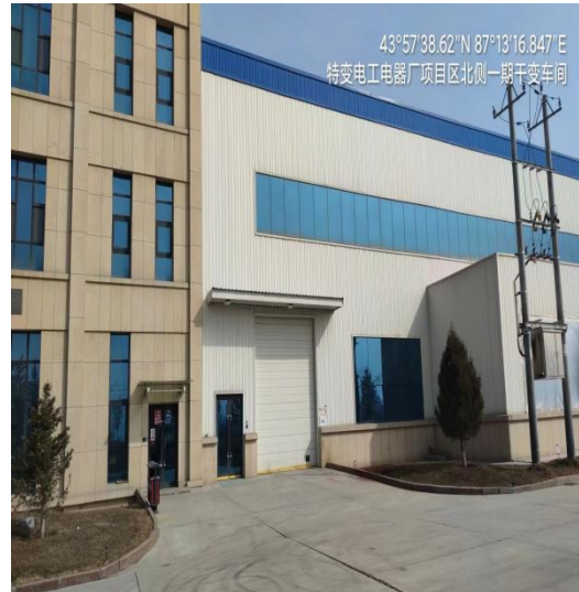
43°57'38.62"N 87°13'16.847"E 特变电工电器厂项目区北侧一期干变车间 项目区北侧车间
