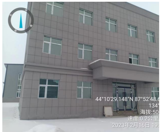
项目租赁办公生活楼现状
