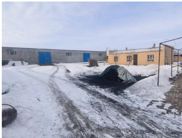
项目区北侧 现场勘察图
