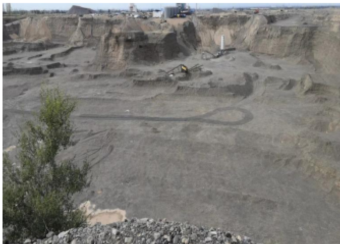
南侧采坑现状
