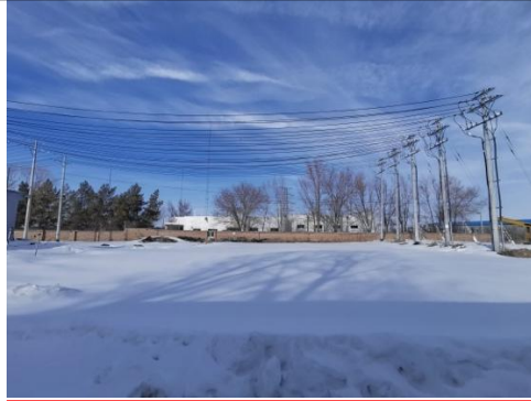
木垒变电站厂界南侧现状
