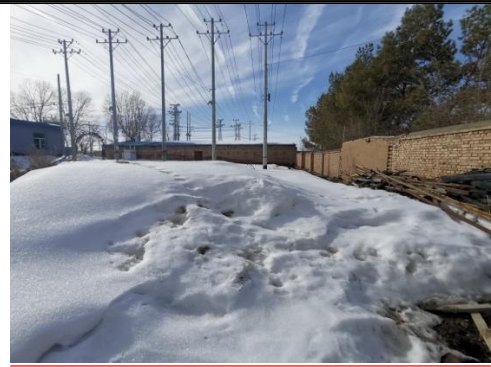
木垒变电站厂界东侧现状
