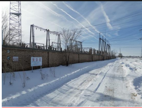
木垒变电站厂界北侧现状
