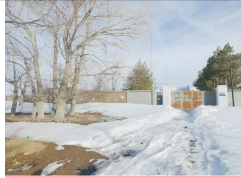
木垒变电站厂界西侧现状
