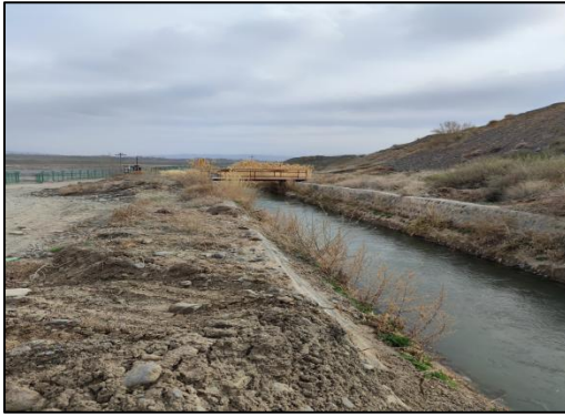
独山子分干渠现状
