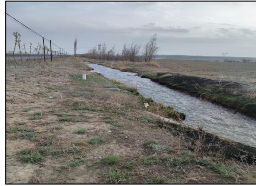
独山子分干渠现状
