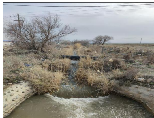
龙王庙二队支渠现状
