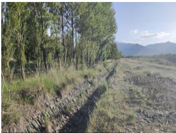
六户地上横路支渠现状
