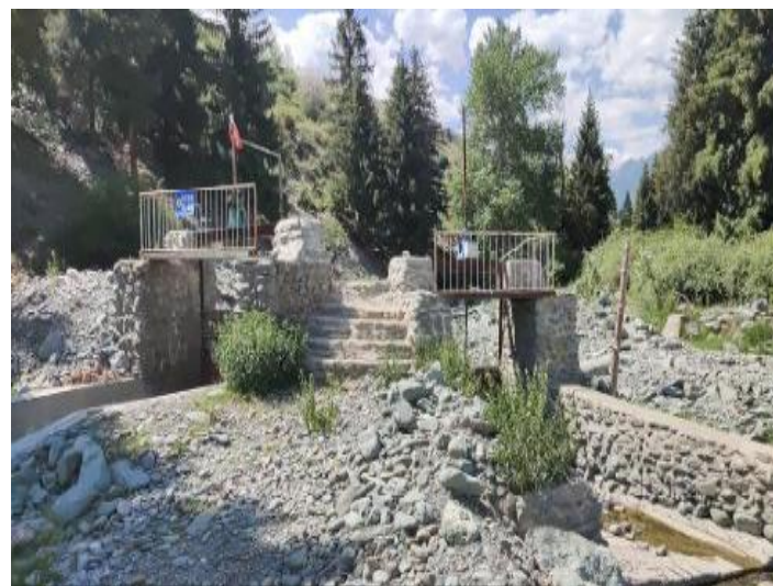
上小分子引水闸现状
