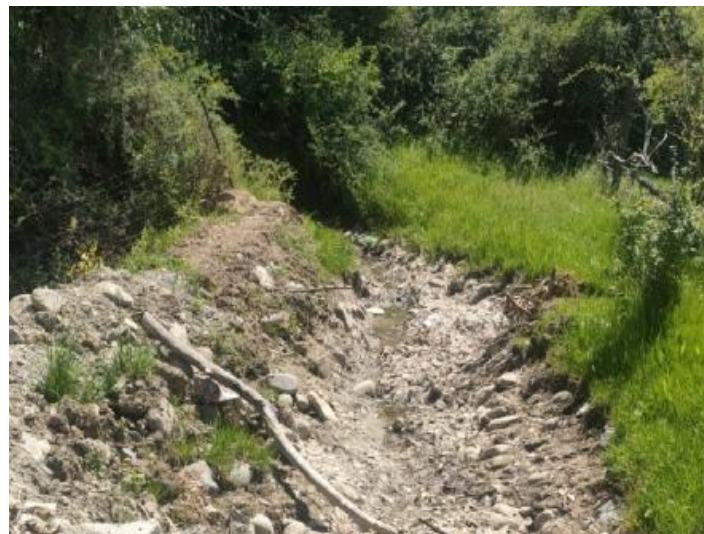
新地河系下小分子干渠现状
