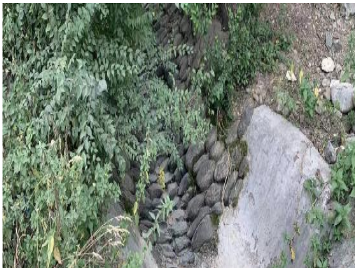
小西沟西支渠现状
