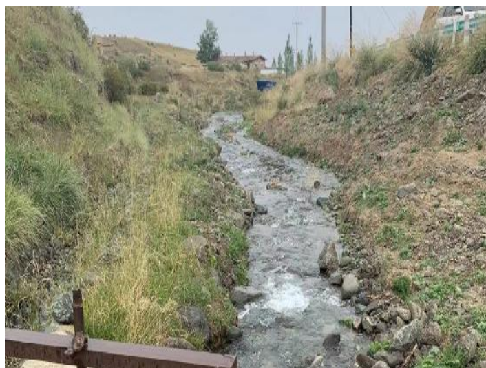
曹家山东支渠现状
