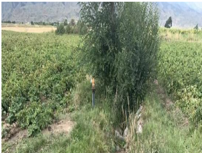
照壁村支渠现状
