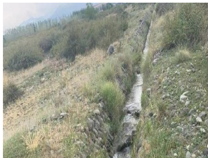
曹家山西支渠现状
