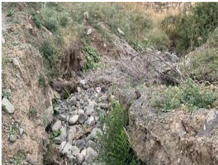
公圣九组支渠现状
