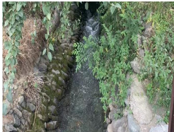
小西沟东支渠现状
