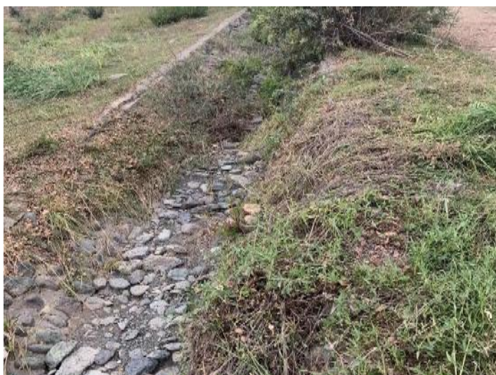
罗家槽子支渠现状
