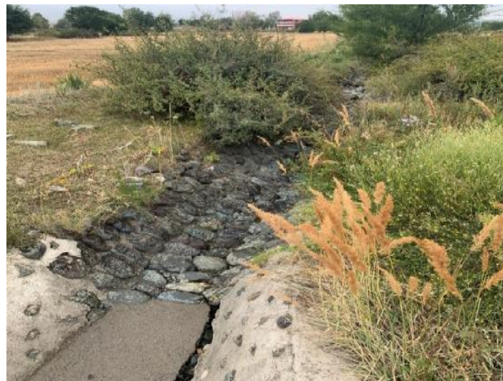
夹河子村中支干渠现状
