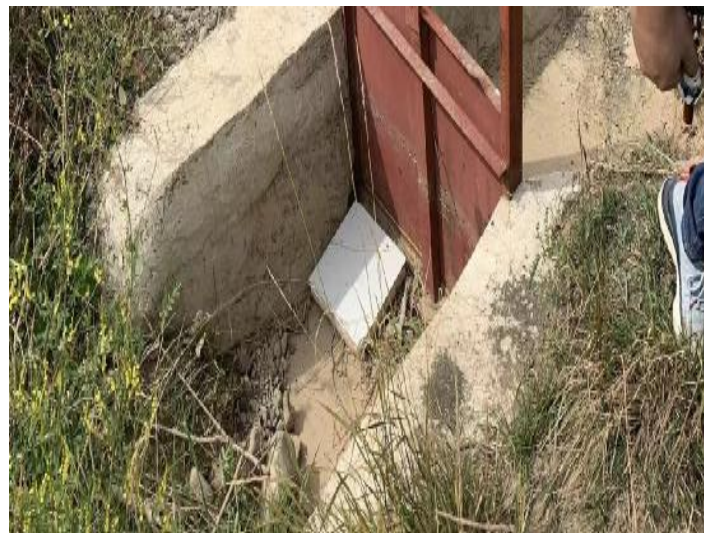
照壁村六组支渠现状
