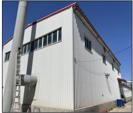
厂区内锅炉房现状
