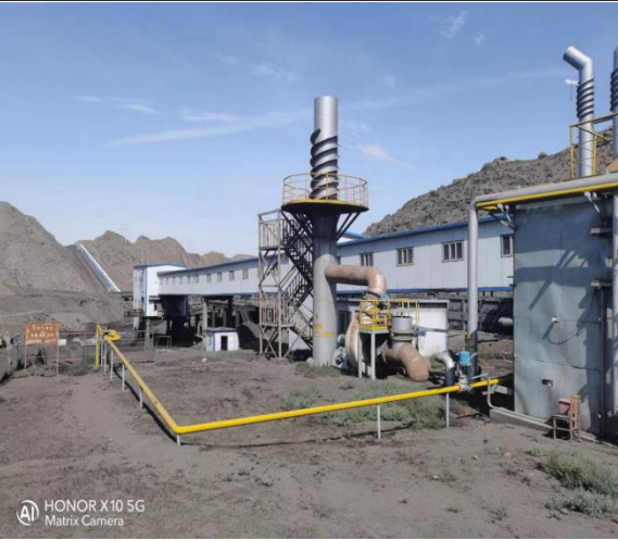
热风炉烟气排气筒
