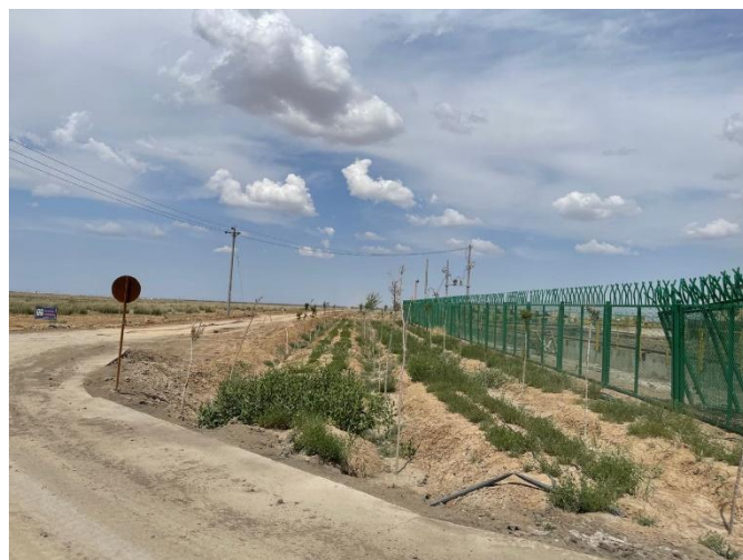
厂区东侧道路
