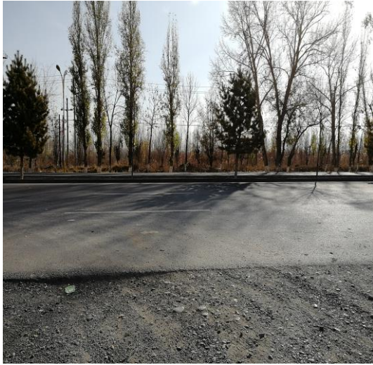
项目东侧 158 县道
