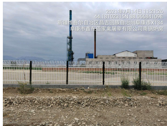
项目区南侧锅炉房
