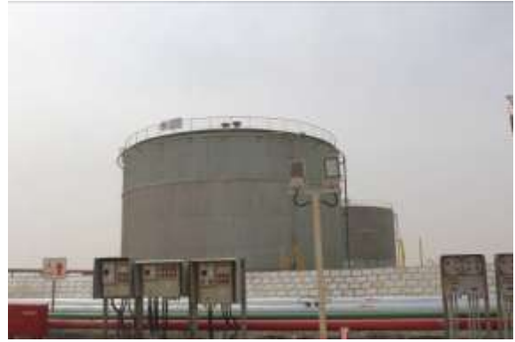
北三台泵站罐区拟改造 5#罐
