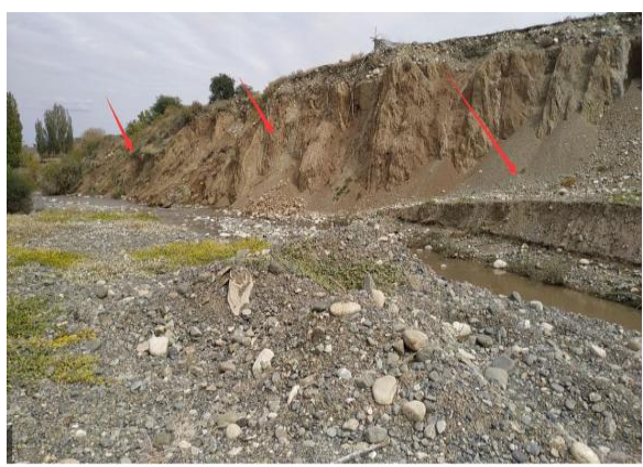
石建房渠首下游河道
