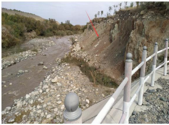
石建房渠首下游河道
