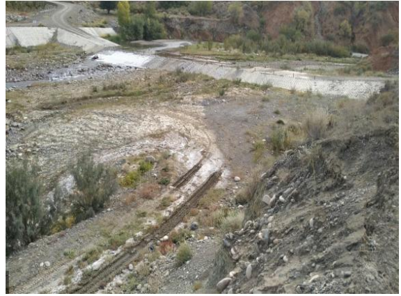
石建房渠首上游河道
