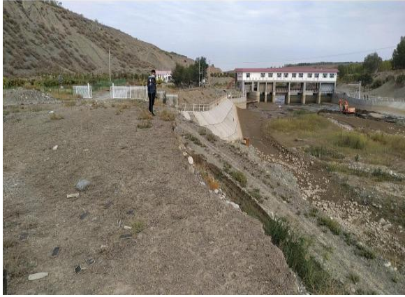
石建房渠首上游河道
