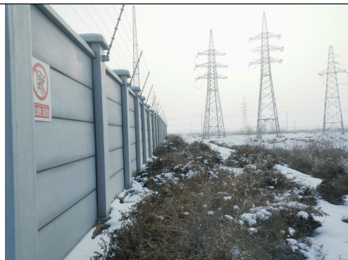
永丰变电站厂界东北侧现状
