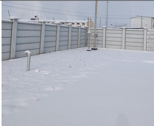
永丰变电站原有事故油池
