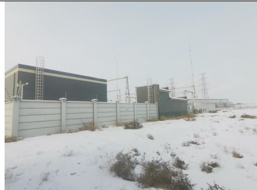
永丰变电站厂界东南侧现状
