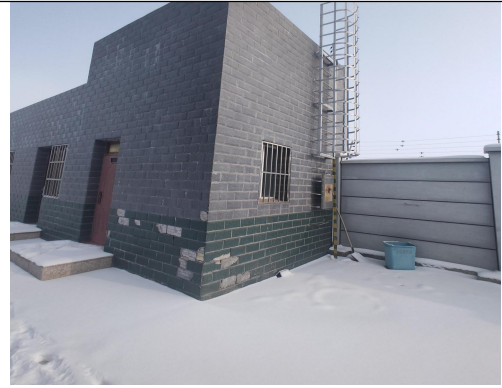
永丰变电站污水井
