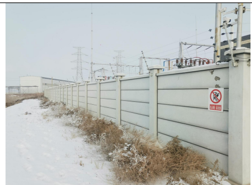
永丰变电站厂界西北侧现状
