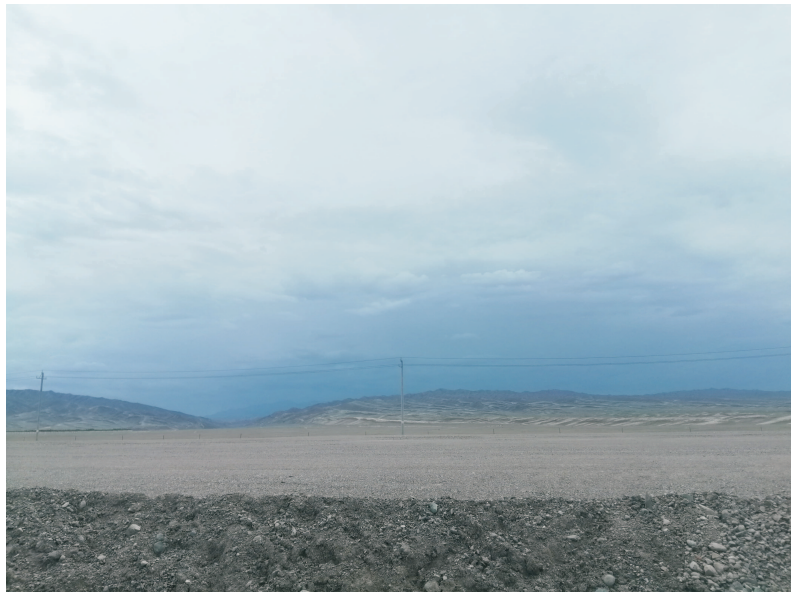
园区北面在建公路现状
