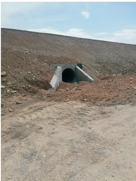
园区北面公路涵洞
