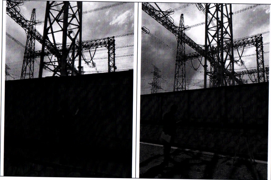
图 2 本工程监测实景图
