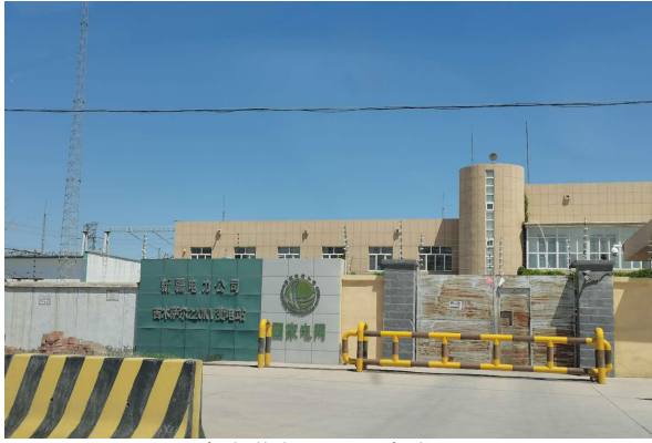
吉木萨尔 220kV 变电站
