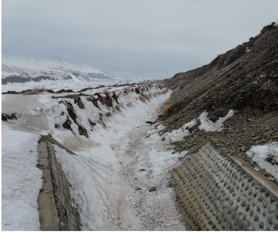
现状渠道情况
