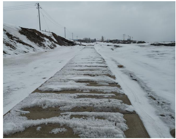
现状盖板渠道
