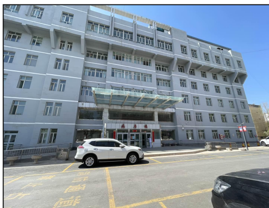
西侧病房楼（外科楼）
