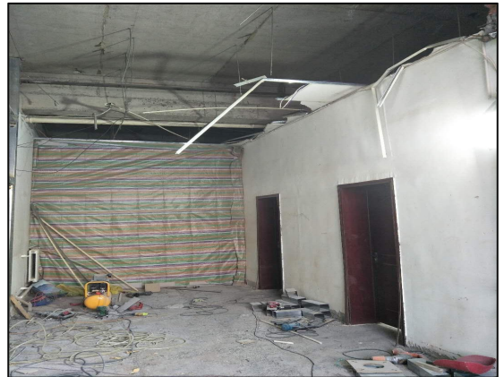
拟建机房墙体
