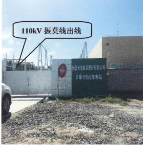
附图 1 天硕 110kV 变电站
