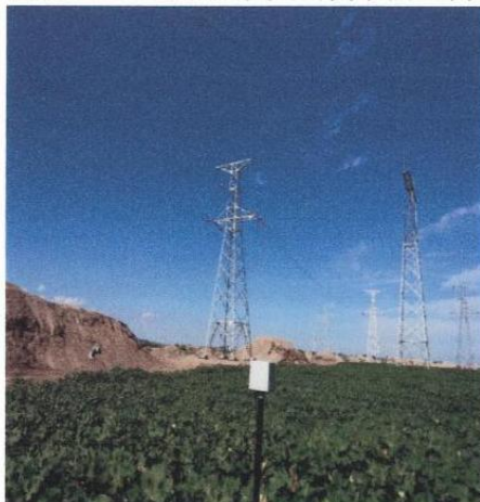
附图 6 8-9 号塔间线路下断面监测
