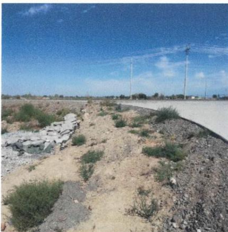
附图 5 110kV 华硕线跨越 S312 处
