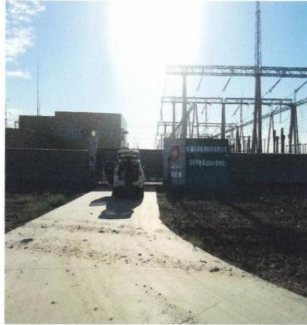
附图 2 220kV 光华变电站
