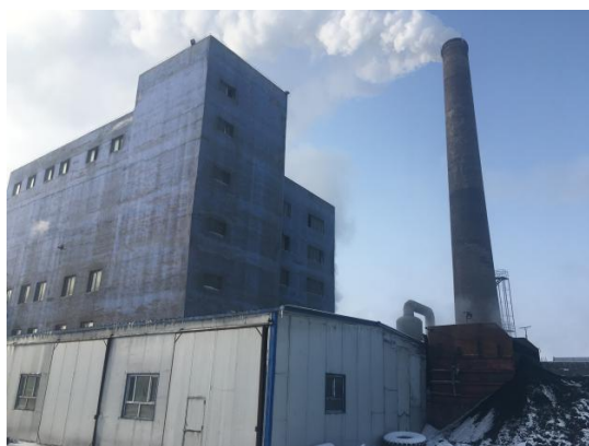
35t/h 锅炉房及烟囱
