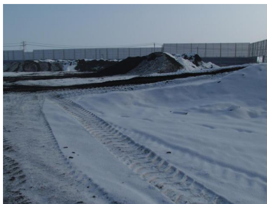
新建锅炉房位置
