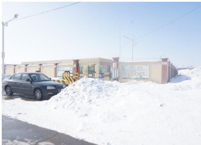
项目区南侧明德配气站
