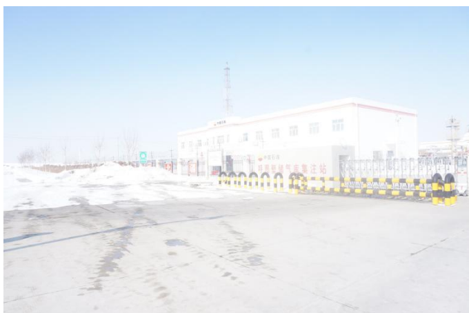
呼图壁储气库
