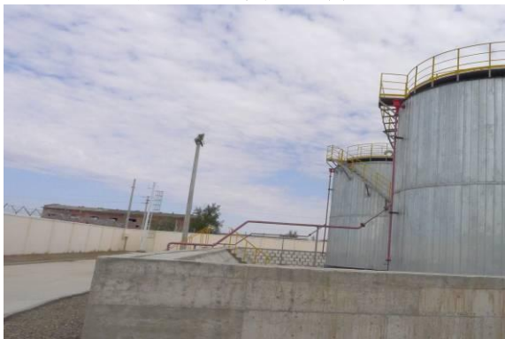
项目油罐及北侧
