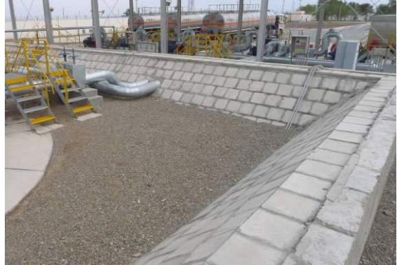
扩建项目油罐围堰
