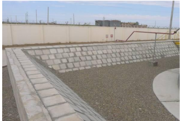
项目围堰及西侧
