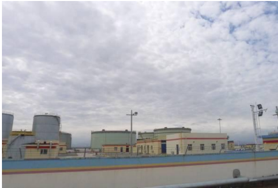
项目区南侧原油库区
