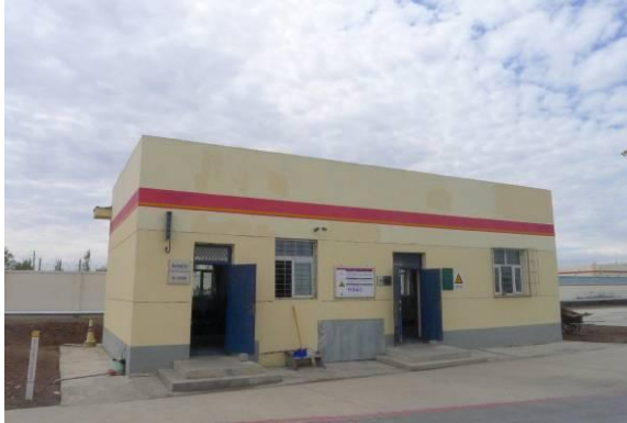
扩建项目值班室及实验室
