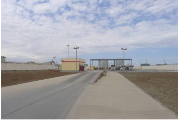
扩建项目全貌
