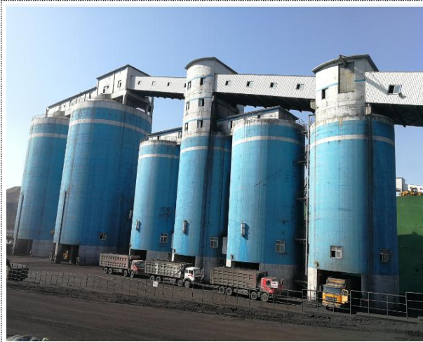
矸石仓、块煤仓、末煤仓
