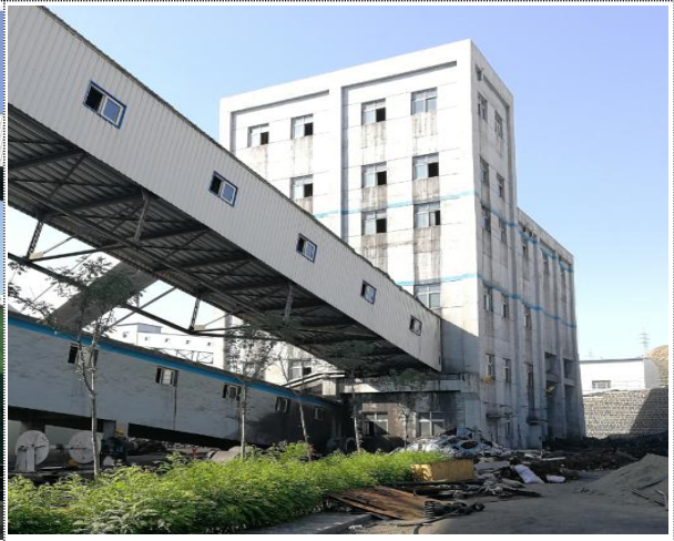
筛分车间全封闭输煤廊道
