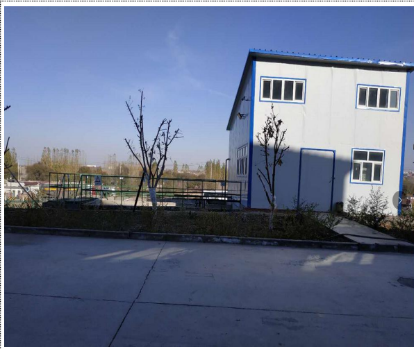
废水处理设施
