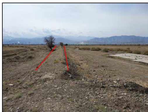
二级电站厂房上游输水管道现状
