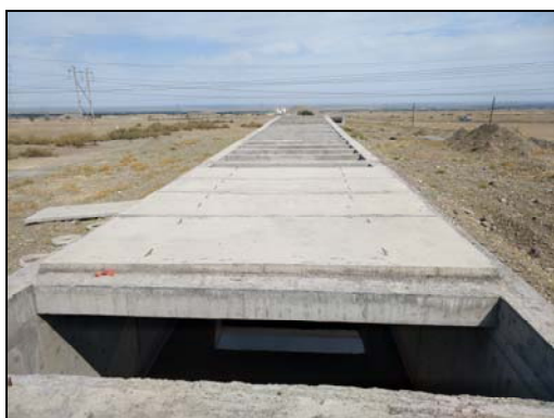
二级电站厂房东侧消力池
