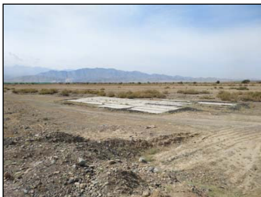
二级水电站厂房拟建地
