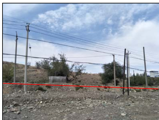
甘河子水库输水管道现状(二)
