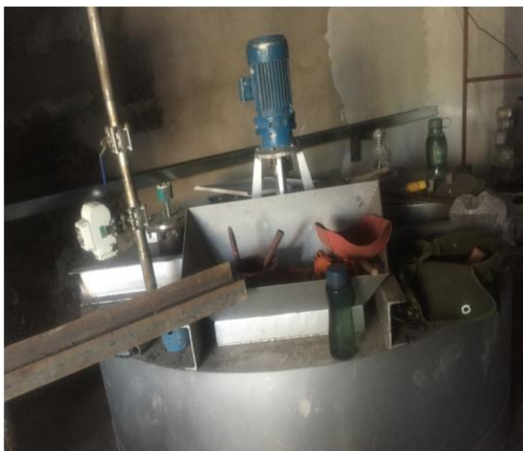
照片 1 尿素溶解罐
