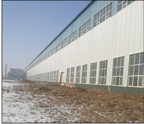
拟建项目厂房南侧
