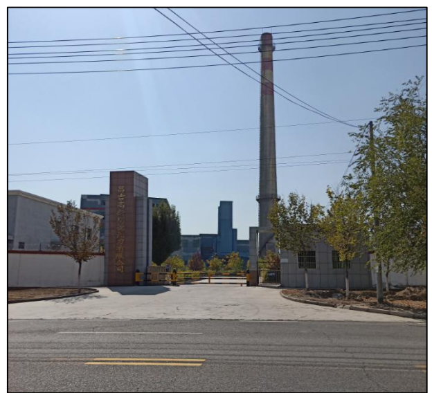
项目区南侧昌吉高新明德热力有限公司
