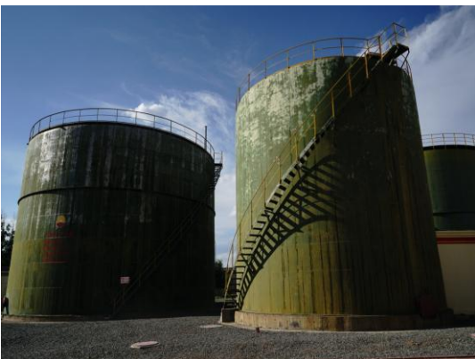
北三台站注罐
