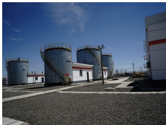
吉祥站注水罐
