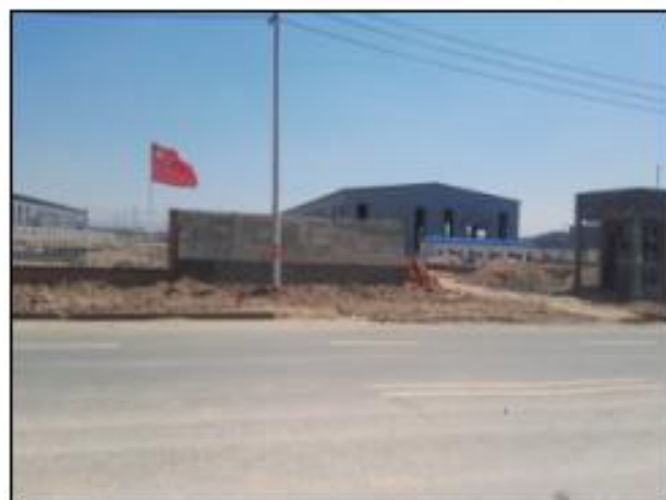
项目区东侧园区道路
