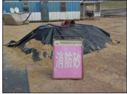
消防砂防尘措施
