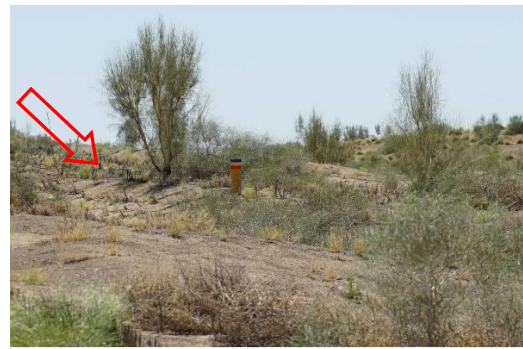
石西油田管线上方草方格及植被恢复情况
