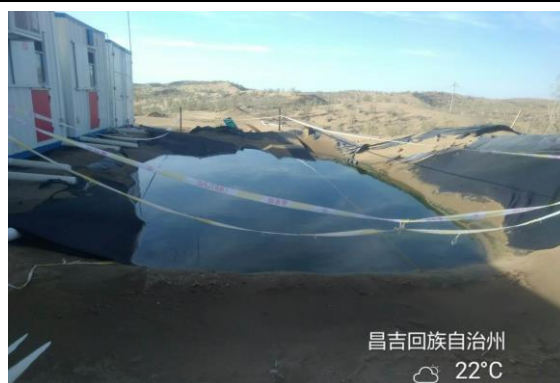
MBHW902 井生活污水防渗蒸发池
