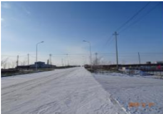
厂区南侧道路
