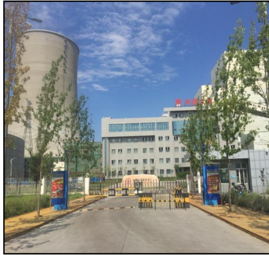
大唐呼图壁能源开发有限公司热电厂
