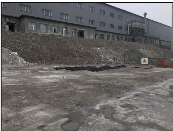
拟建脱硫除尘装置区
