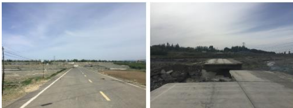
Z903 木垒大桥段已被冲毁
