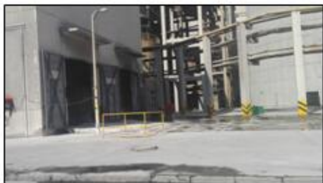
脱硫石膏暂存间
