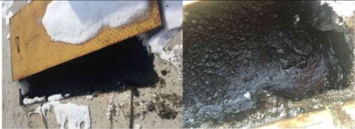
图 2 调节池设备孔处浮泥
