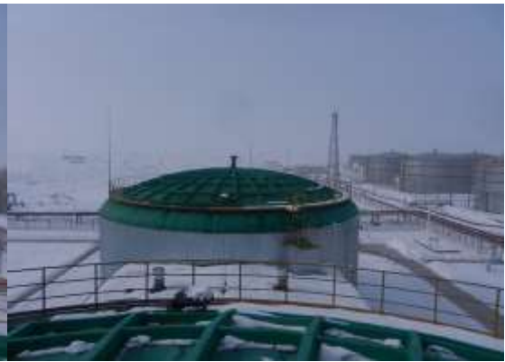
装置区西侧现状
