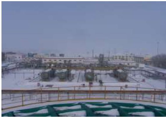
装置区北侧天然气压缩处理站
