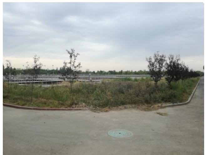
污水处理厂现状
