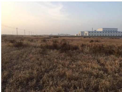
厂址南侧中凯碳素厂
