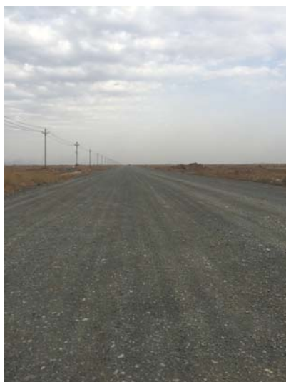
厂址东侧道路
