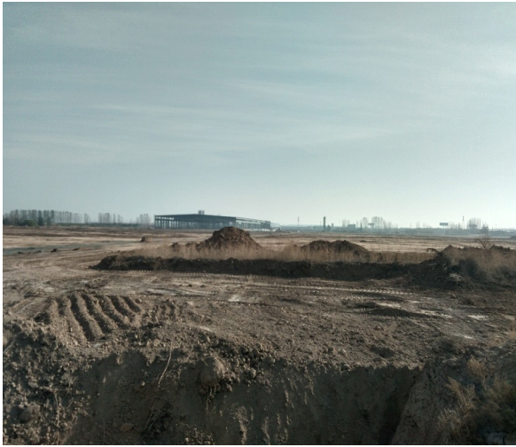
厂区东侧力高公司
