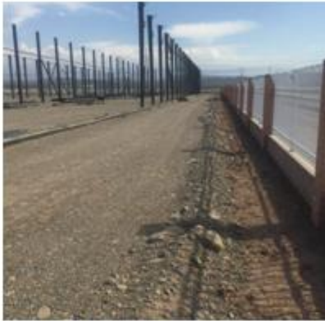
东侧道路及空地
