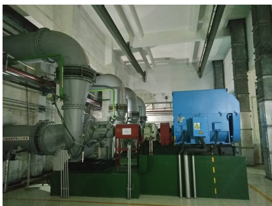
脱硫综合楼内
