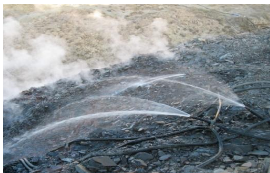
图 2.4-1 火区地表注水
