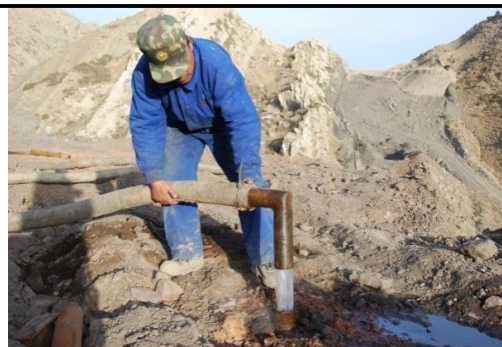
图 2.4-4 钻孔注水
